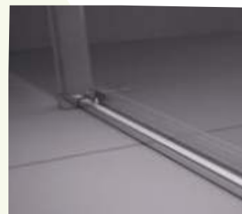
Barre de seuil inférieure avec guide de fixation
